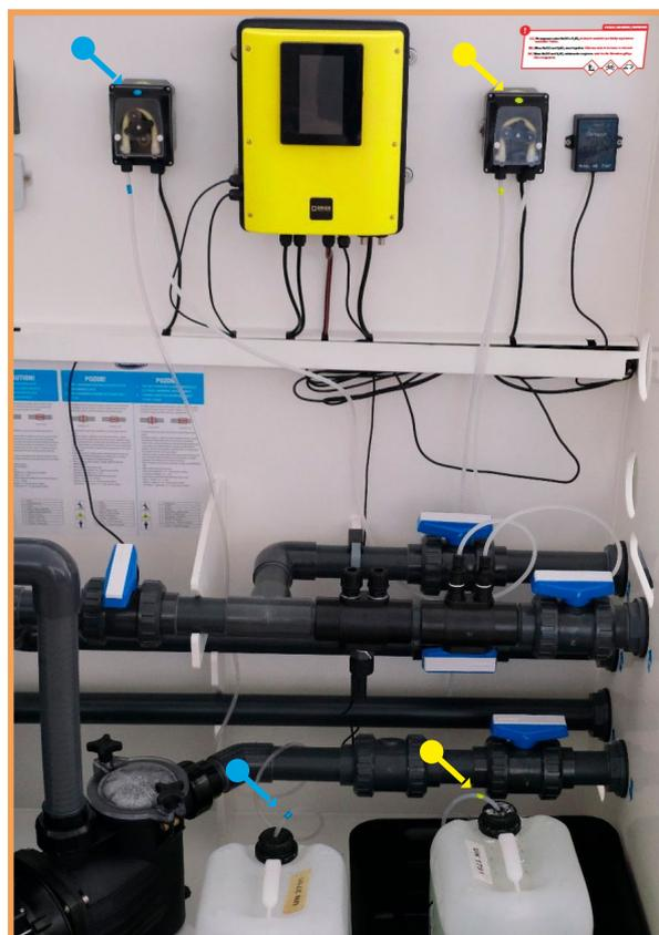
Die Dosierpumpen sind farblich so gekennzeichnet, dass die Dosierchemie mit den Farben der pH- und Redox-Sonden übereinstimmt. Verwenden Sie die blau markierte Dosierpumpe ausschließlich zur Dosierung von Schwefelsäure und die gelb markierte Dosierpumpe ausschließlich zur Dosierung von Natriumhypochlorit. Vertauschen Sie niemals die Schläuche, die die Chemikalien zur Dosierpumpe führen, um eine Vermischung der Chemikalien und die Freisetzung von Chlorgas zu vermeiden.
